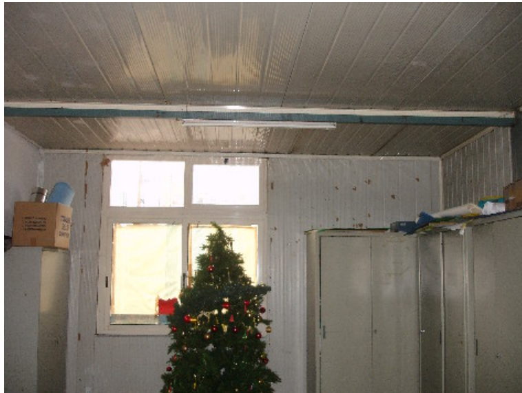
Locale ad uso deposito di nuova realizzazione
