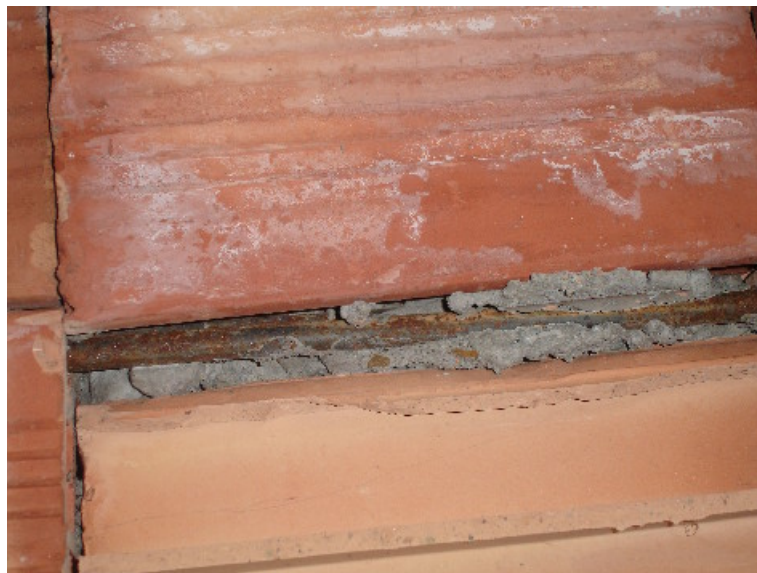
Armatura presente sul solaio di copertura
