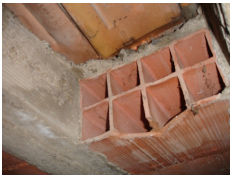
Solaio di copertura
