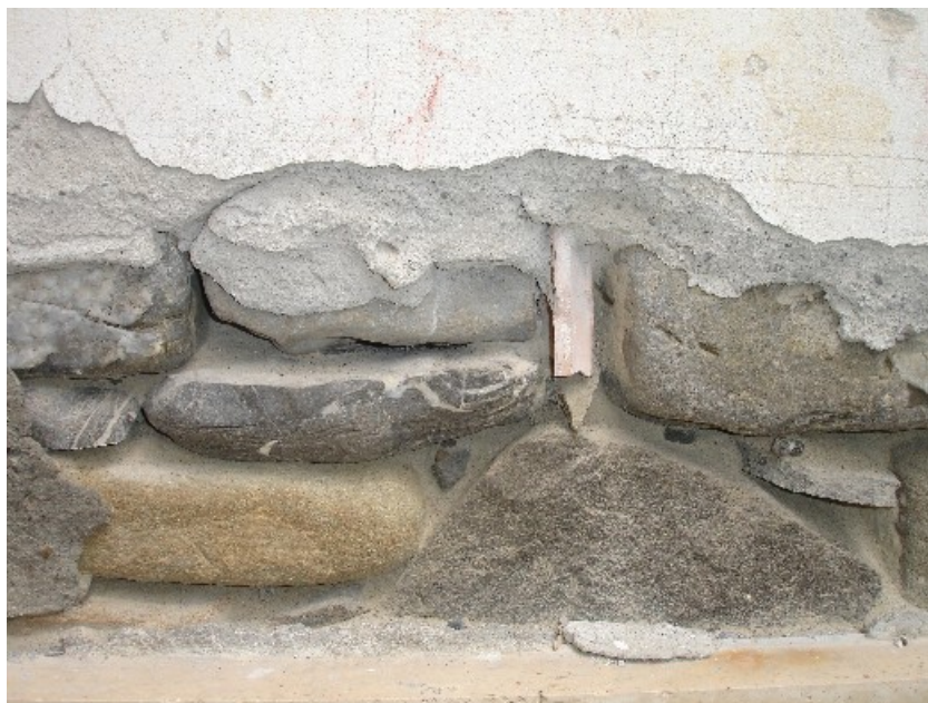
Muratura esterna posta al piano interrato
