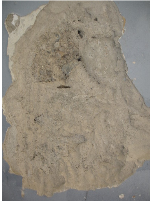
Muratura posta sulla facciata posteriore del primo piano
