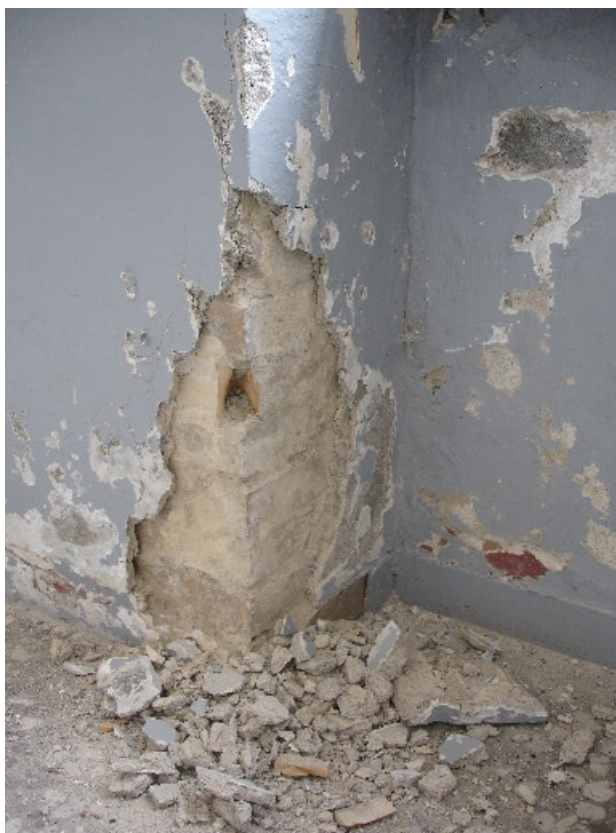
Pilastro in muratura posto sulla facciata principale dell'edificio
