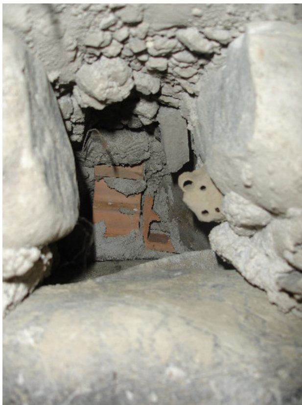
Intercapedine realizzata nel muro
