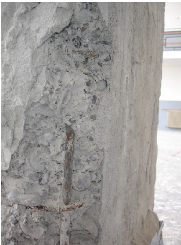
Pilastro 30x50: evidente vacuolarità del cls.
