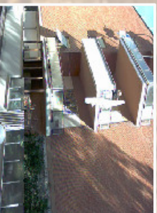
Manutenzione ordinaria del prospetto e trattamento delle superfici in cortina
