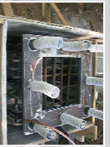
Particolare di una di fondazione
